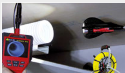
Inspection de la ventilation et maintenance
