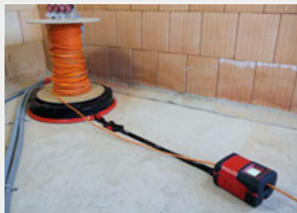
RM35 mit Gurt und Clipsystem an XB 500 befestigt
