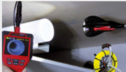
Lüftungs- und Wartungsinspektion
