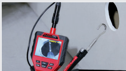
Inspection de parois creuses
