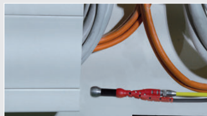
Schächte und Unterflurkanäle
